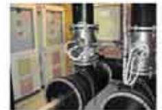
Os equipamentos para tratar água de mar podem ser em AISI 316 + tratamento anti-corrosivo ou em polietileno de alta densidade (HDPE).
